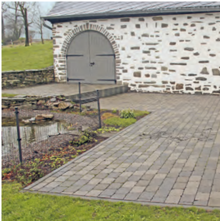
5. Farbschwankungen aufgrund der Lieferung aus unterschiedlichen Lieferwerken.
