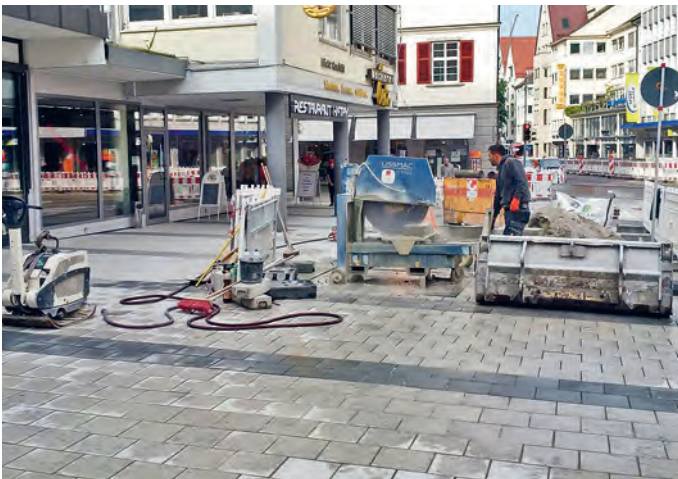
14. Von außen eingetragene Schneidschlämmen.
