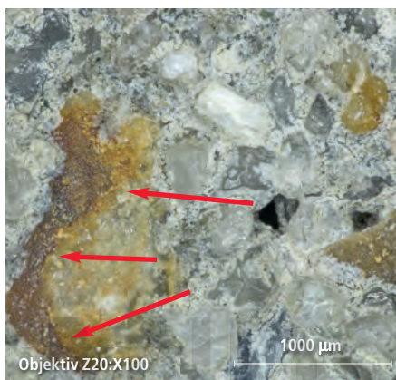
8. Braune Verfärbung durch zersetzliche, eisenhaltige Gesteinskörner in der Produktoberfläche.
