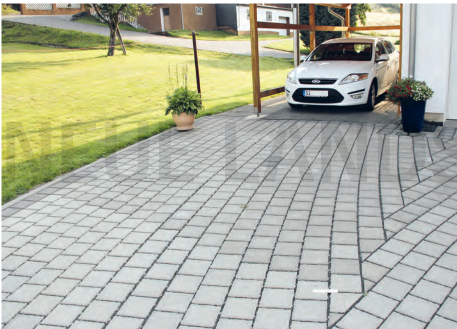
13. Palettenweise Verlegung von Betonpflastersteinen.
