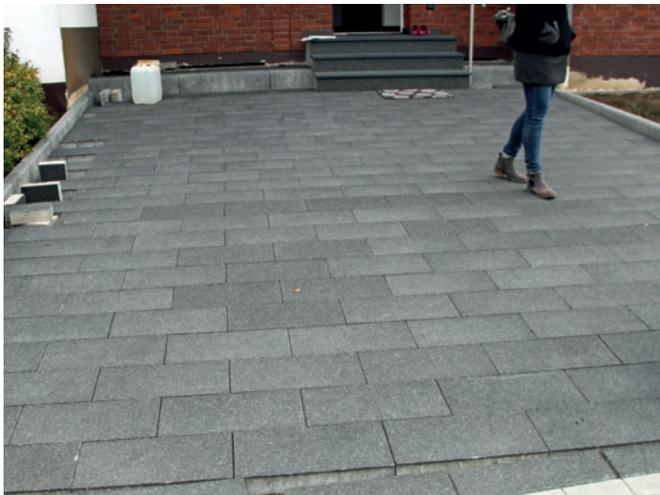
Abb. 8: Aufhellung vergüteter Betonplatten
