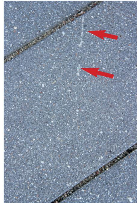
Abb. 6: Pflasterdecke mit zum Teil verkratzten Betonplatten
