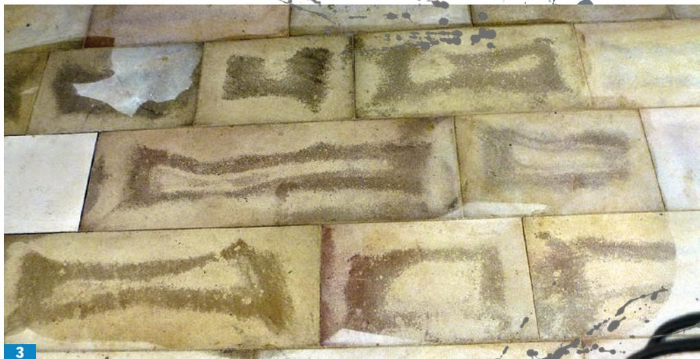
des Belags, aufgrund einer für das ausgewählte Material übermäßigen Verschleißbeanspruchung oder aufgrund des unvorhergesehenen Eintrags von schädigenden Substanzen etwa durch den Einsatz von Taumitteln. Zu dieser Art von Folgekosten wird dem Planer/Ausführenden nur die dringende Empfehlung an die Hand gegeben, im Vorfeld mit dem Auftraggeber sehr genau die geplante Nutzung abzuklären und dies dann auch in der Kauf- oder Liefervereinbarung schriftlich festzuhalten.
