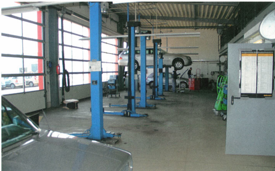
Bild 1: Industrieboden in der Autowerkstatt
