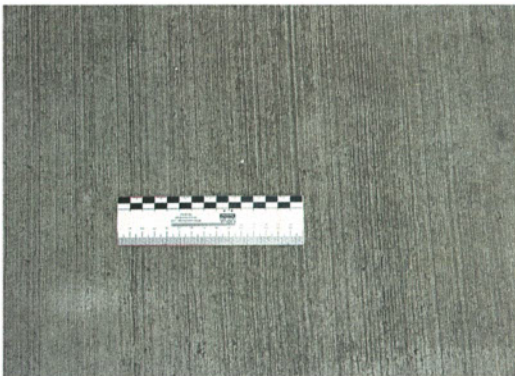
Bild 2: Ausgeführter Besenstrich
