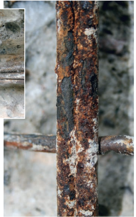
Bild 7: Freigelegter Bewehrungsstahl
