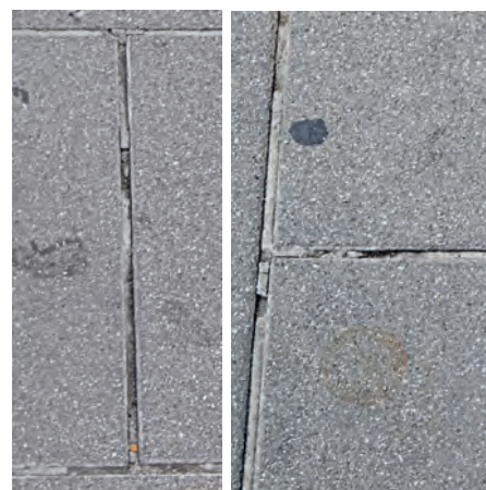
7. Herausgewitterter Fugenmörtel.
