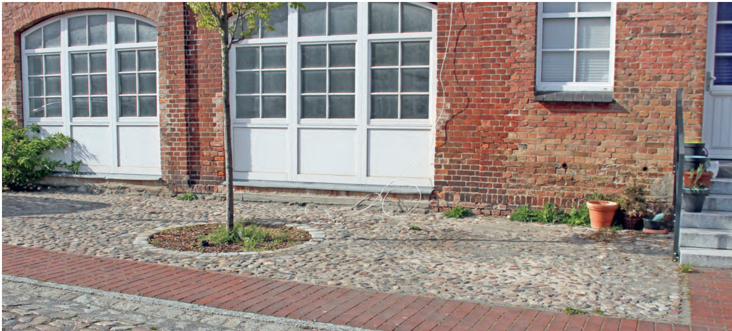
8. Frost-Tausalz-Abwitterungen am Fugenmörtel einer gebundenen Pflasterdecke.
