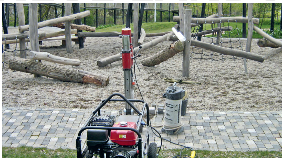
1. Zu beurteilende, gebundene Pflasterdecke.
