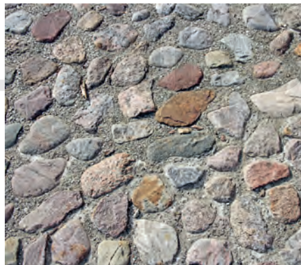
8. Frost-Tausalz-Abwitterungen am Fugenmörtel einer gebundenen Pflasterdecke.
