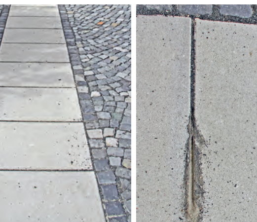
5. Als Fugenmörtel verwendeter Zementmörtel.
